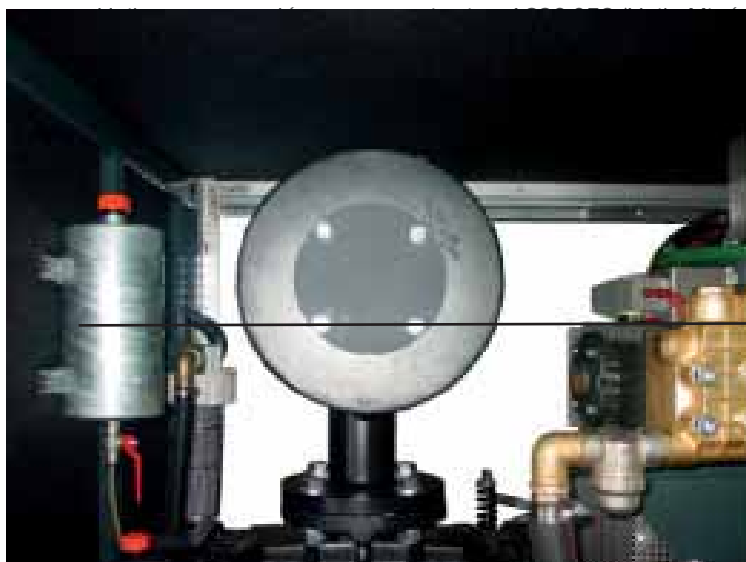
Réservoir de vaporisation
